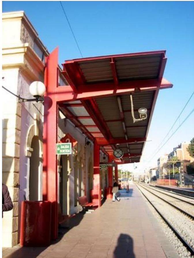
Marquesina añadida al edificio
