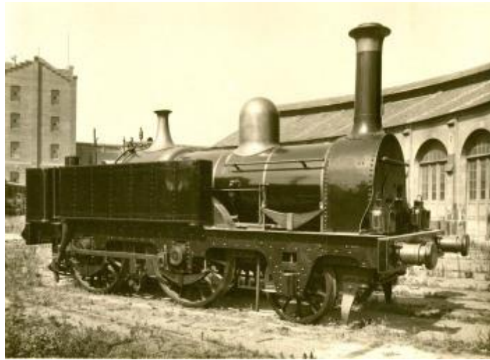
Locomotora Martorell, imagen restaurada con tanques laterales, fondo MFC
