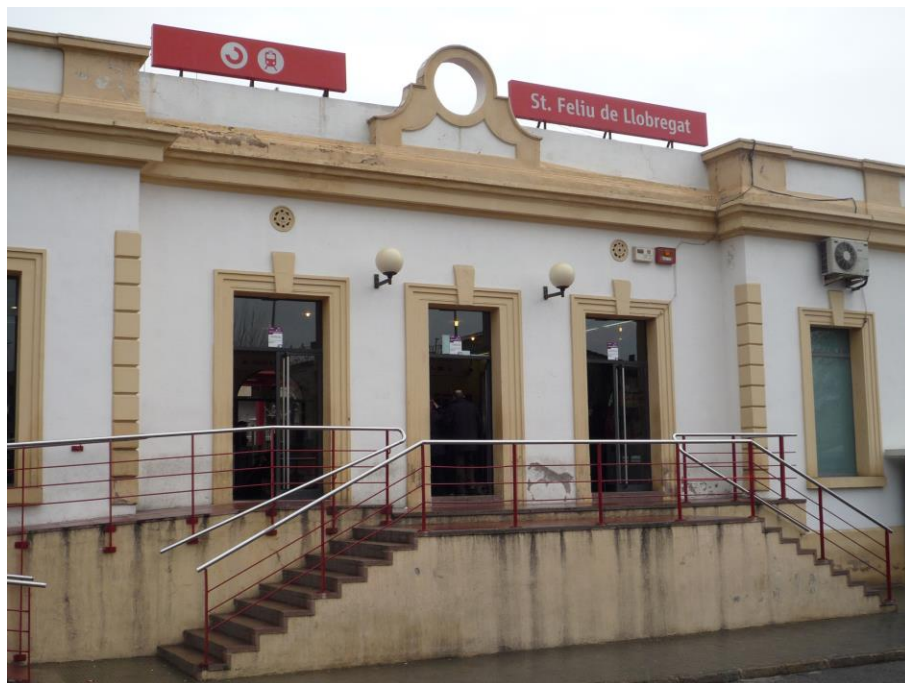
Rampa y escaleras de acceso añadidas en la reforma de 1991
