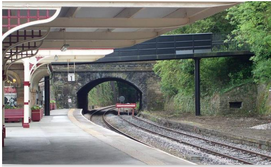
Puente en Belper Railway Station (1840), en la línea de Derby-Chesterfield
