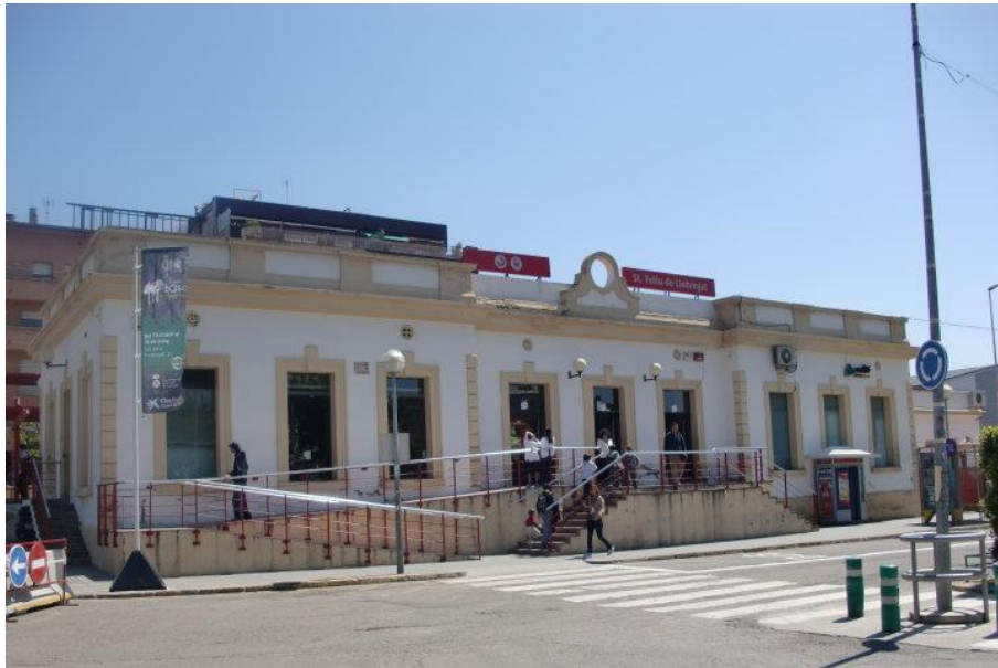
Vista de la fachada de la entrada de la estación
