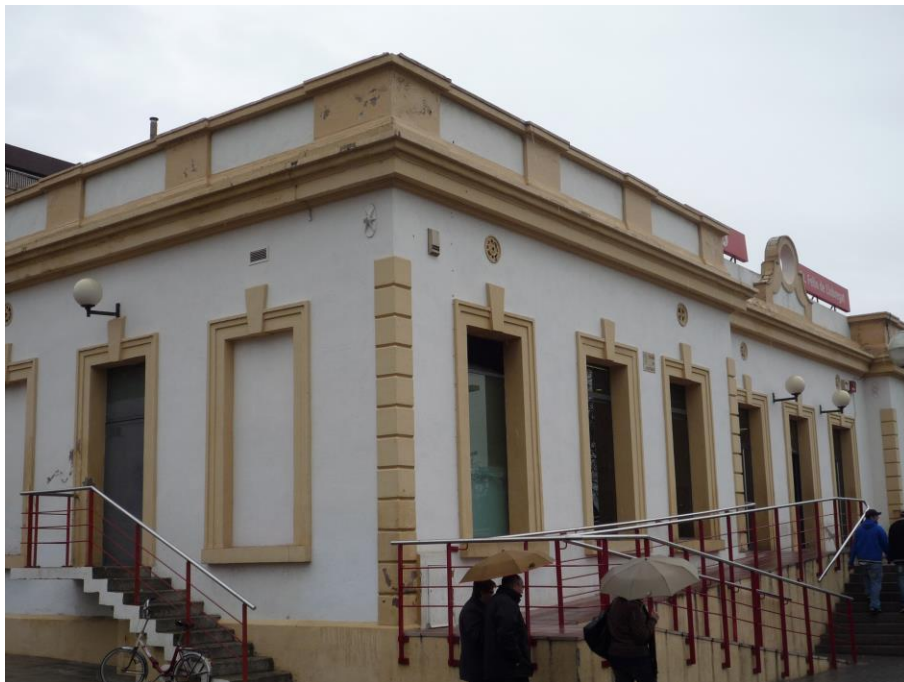
Detalle de la fachada de la entrada principal
