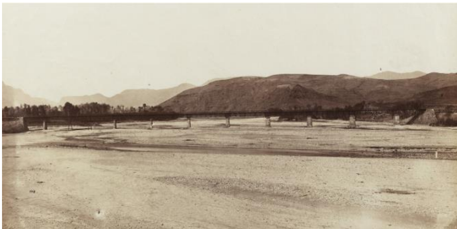
Michel de Bergue. Viaducto ferroviario de Martorell sobre el río Llobregat, línea de Barcelona a Martorell (dos tramos extremos de 17 m y nueve tramos de 27,40 m), 1859.
