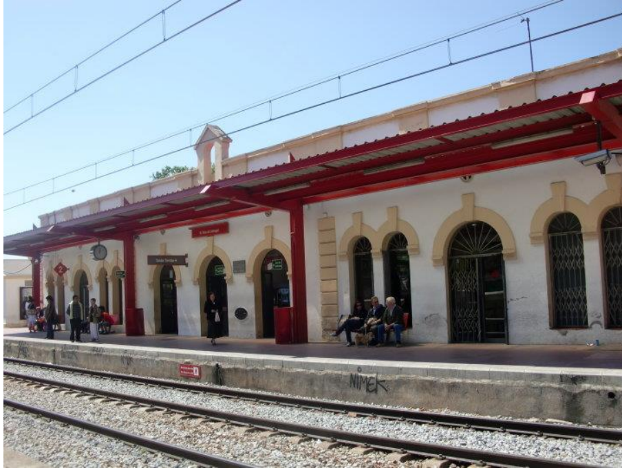
Fachada de acceso a los andenes
