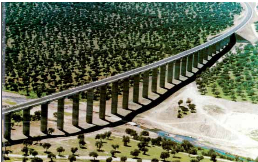
Avanzan las obras del Ave y llega la primera 252
