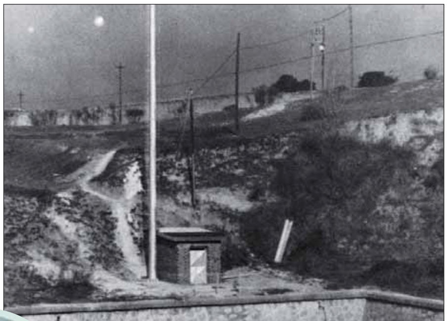
Comenzaban los ensayos del tren-tierra.
