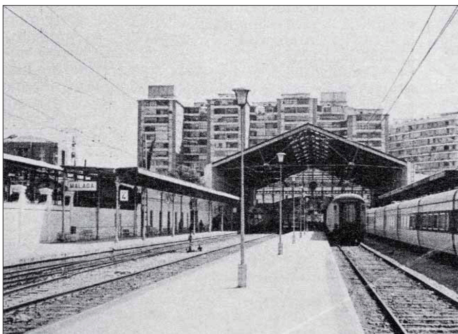
Culminada la electrificación del Córdoba-Málaga.
